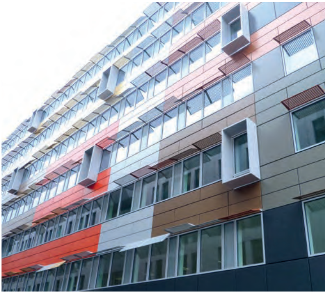
MONTREUIL (93) - B Initial - 7 rue des Longs Quartiers
